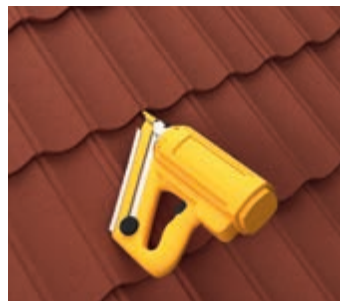
РИС.12.2 Крепление пневмопистолетом
