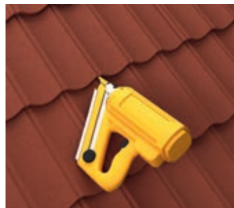
РИС.12.2 Крепление пневмопистолетом
