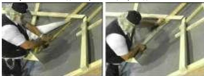
приклеивается двухсторонняя самоклеющаяся лента пояс подкровельной пленки к ендове. Контрбрус к ендове крепится саморезом, под который наклеивается уплотняющая клейкая лента во избежание течи в ендове. Обрешетка, размещенная в ендове необходимо подрезать на глубину 15 мм, чтобы закрепить желоб
