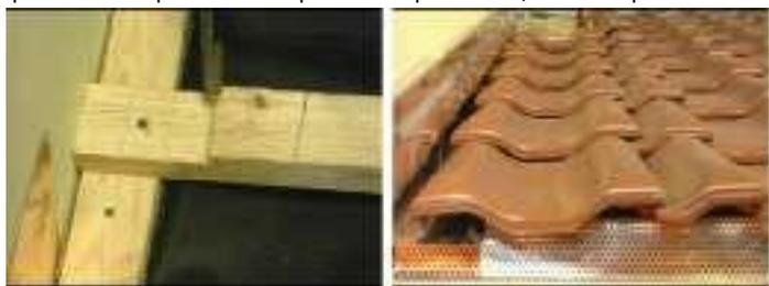
случае необходимости применяется половинчатая черепица перед укладкой двухволнистой черепицы. После монтажа верхней планки примыкания укладку каждого ряда закрывает двухволновая черепица. Это влияет на эстетику отделки ската кровли.
