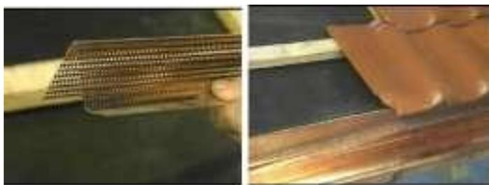
подкровельной гидроизоляционной пленки. После плотной укладки подкровельной мембраны монтируется гребень свеса из перфорированного металлического профиля. Перфорация уголка должна иметь 62 %, что при высоте в 65 мм дает 400 см впуска воздуха на погонный метр.
