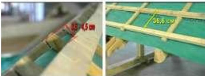
Необходимо отметить на коньке контрбруса место размещения подконьковой рейки. Расстояние от верхней точки до начала этой рейки зависит от угла уклона ската кровли (35-45 мм). Когда длина ската кровли не превышает 6 метров применяется контрбрус толщиной 24 мм, при длине ската до 12 метров применяется контрбрус толщиной 28 мм, при длине ската кровли более 12 метров применяется контрбрус толщиной 40 мм. После обозначения места закрепления последней рейки считая от конька
