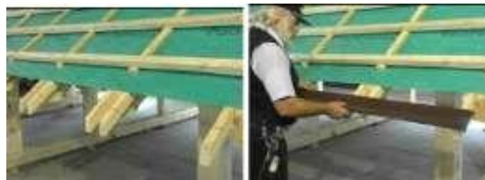
черепиц. Укладывать необходимо верхней стороной вниз вертикально на смещение и размещение так, чтобы передние складки сцеплялись. Размеры на смещение и размещение между первой и последней черепицей суммируется и делится на 20. Средняя величина реек составила 366 мм. Максимальный допуск к расстоянию погрешность около 3 мм. Поэтому допускается шаг обрешетки выполнять в диапазоне от 366 до 369 мм. Затем на
