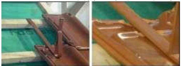
требуется закрепить противовеетровым зажимом во избежание вреда вызванного влиянием атмосферных явлений. В зависимости от длины кровли вычисляем расположение вентиляционных черепиц. Кровли длиной до 4.5 метров не укладываются вентиляционные черепицы. Если кровля имеет длину до 7 метров укладывается один ряд вентиляционных черепиц на высоте три ряда от конька. До 12 метров применяется два ряда вентиляционных черепиц, а выше этой длины первый ряд укладывается на высоте второй черепицы от конька.
