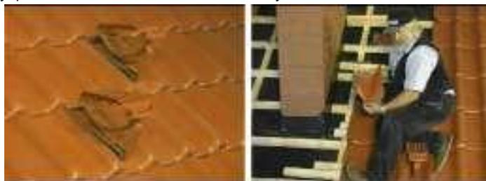
черепице, на которой находится ступень, необходимо сбить горизонтальный замок, благодаря чему получается правильная посадка ступеньки безопасности. Верхнюю черепицу требуется подогнать к ступеньке безопасности через удаление части замка. Примыкание дымохода требуется выполнять с особой старательностью. Для обработки дымохода применяется рифленый самоклеющийся материал на основе алюминия или
