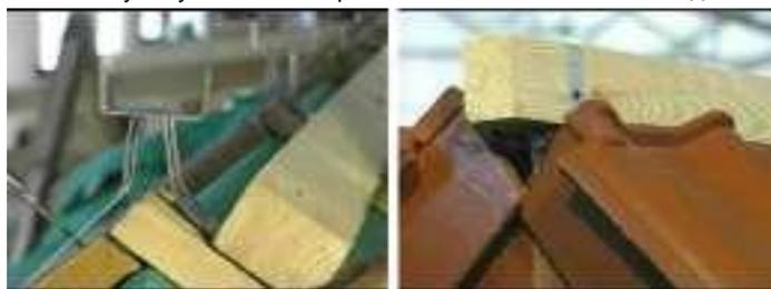
см. Для эффективной вентиляции подконьковой черепицы применяется уплотняющая лента с вентиляционными отверстиями. Также допускается использовать вентиляционные решетки. Под коньковую черепицу рекомендуется применять ленты, изготовленные из алюминия и свинца. Затем укладывается конько-
