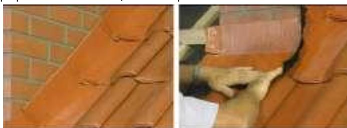
свинца. В случае необходимости черепица дорезается и укладывается при дымоходе. Кромки этой черепицы должны быть обработаны вместе стыка обработок и самоклеющихся
