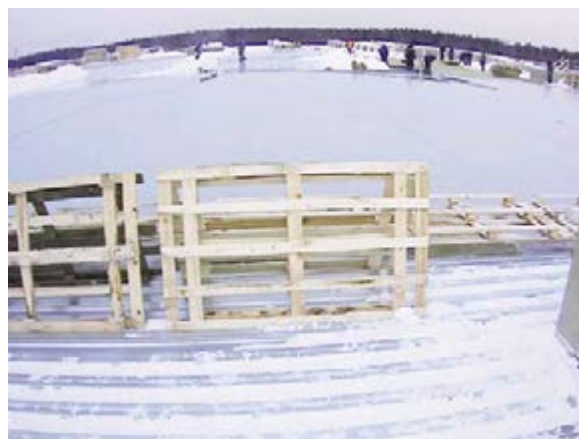
Рис. 3.1.9 Защита края кровельного пирога от хождения
