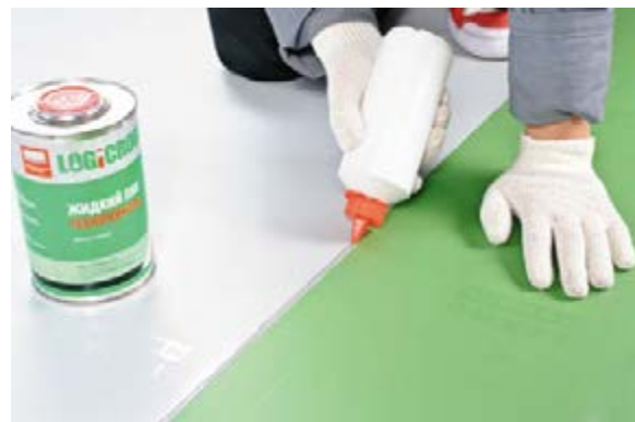
Рис. 3.4.2 Обработка стыка жидким ПВХ
