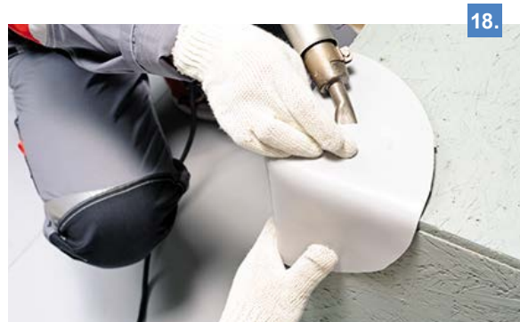
18. Соедините радиусы окружности, так чтобы получилась воронка с перехлестом на величину сварного шва (20 мм). Приложите деталь к углу, и притянув пальцами обе части окружности, точно прихватите их друг к другу феном.
