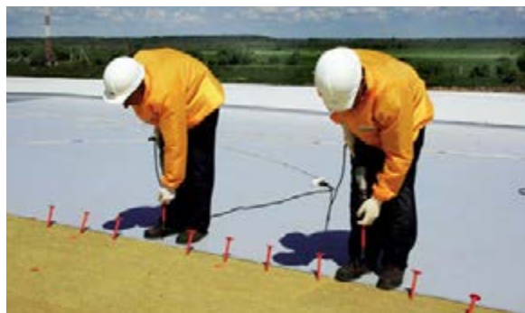
Рис. 5.4.4 Механическое крепление мембраны
