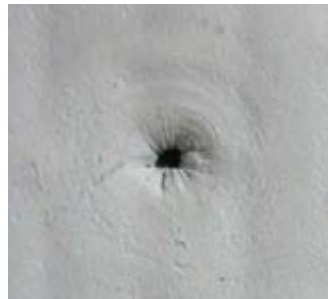
4.3.5 Повреждение на образце мембраны после испытания
