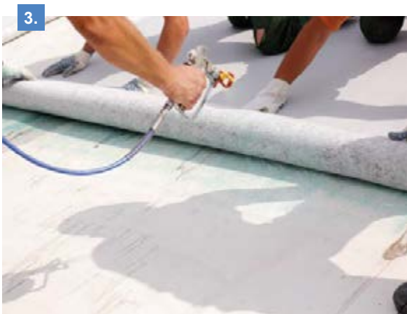
Рис. 2.6.8 Процесс нанесения клея на основание и на мембрану
