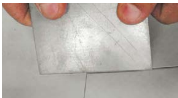
Рис. 5.2.15 Фиксация T-образного шва металлической пластинкой
