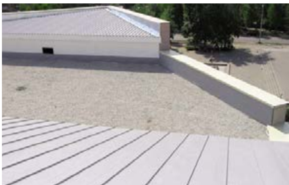
Рис. 2.4.1 Вид балластной кровли
