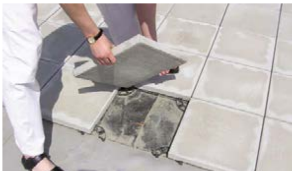
Рис. 2.4.3 Применение в качестве балласта тротуарной плитки
