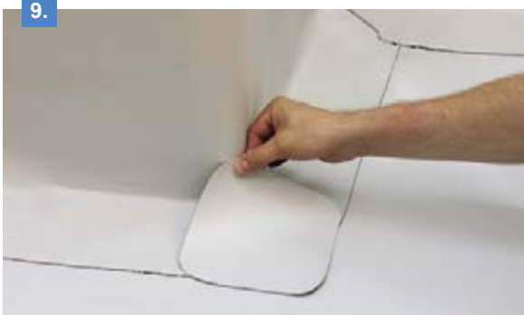
9. Примеряется заготовка детали усиления по месту. При необходимости делается корректировка размера заготовки.
