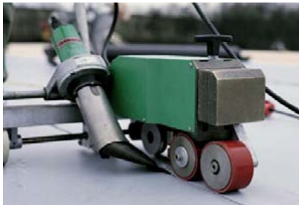
Рис. 5.2.1 Процесс автоматической сварки
