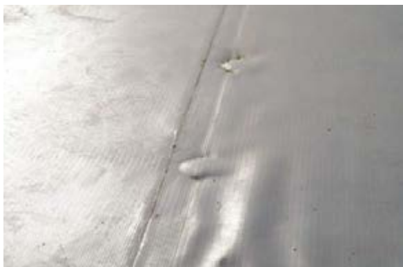
Рис. 3.5.7 Дефект сварного шва
