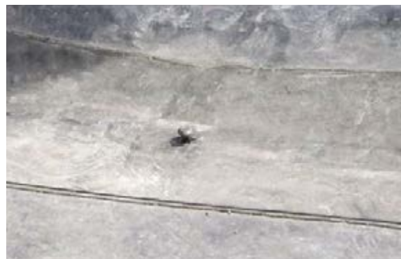
Рис. 3.5.10 Повреждение мембраны шляпкой самореза при применении тарельчатого металлического держателя по минераловатному утеплителю
