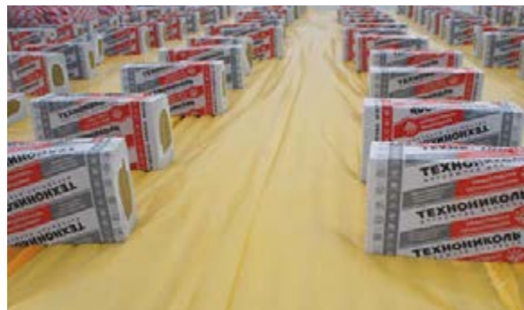
Рис.3.1.4 Укладка пароизоляционной пленки ТехноНИКОЛЬ
