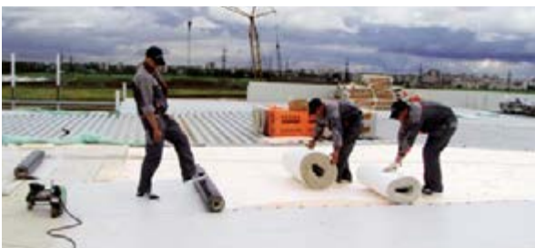
Рис. 2.3.1 Монтаж системы ТН-КРОВЛЯ Смарт
