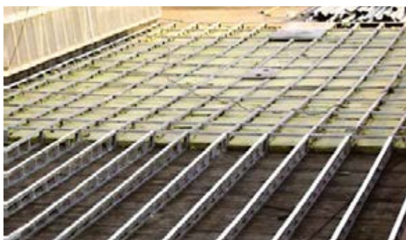
Рис. 3.3.3 Вариант устройства разуклонок
