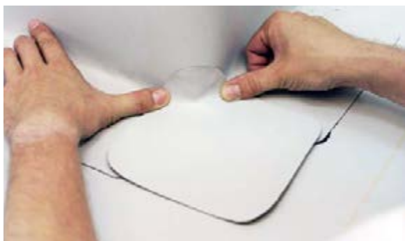
Рис. 3.4.1 Применение неармированной ПВХ-мембраны при устройстве внешнего угла.
