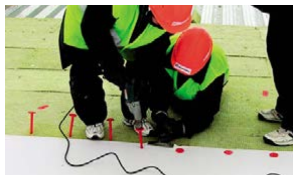
Рис. 5.4.5 Натяжение мембраны
