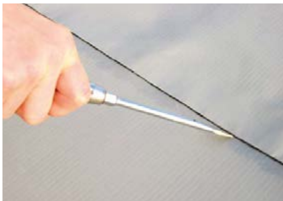
Рис. 5.2.8 Контроль при помощи плоскошлицевой отвертки
