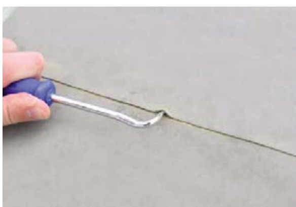
Рис. 5.2.9 Контроль при помощи специальной чертилки
