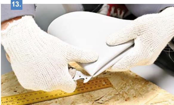
13. Сделайте отверстие с помощью кровельного ножа, для того чтобы найти центр окружности.
