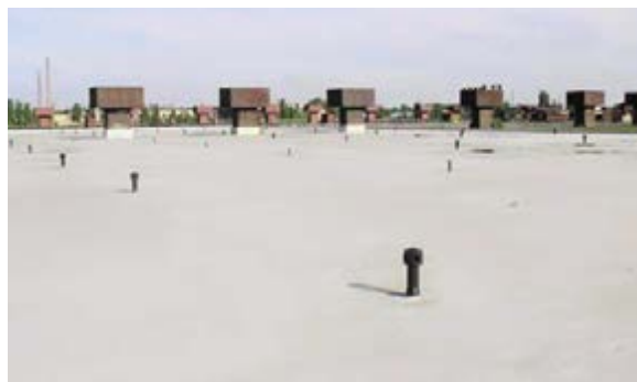
Рис. 2.6.2 Вид кровли после реконструкции полимерными мембранами с доутеплением
