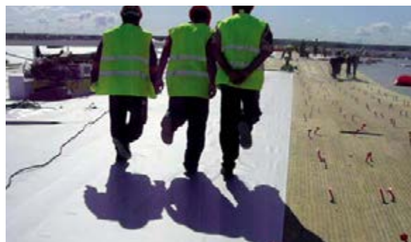
Рис. 5.4.3 Натягивание рулона
