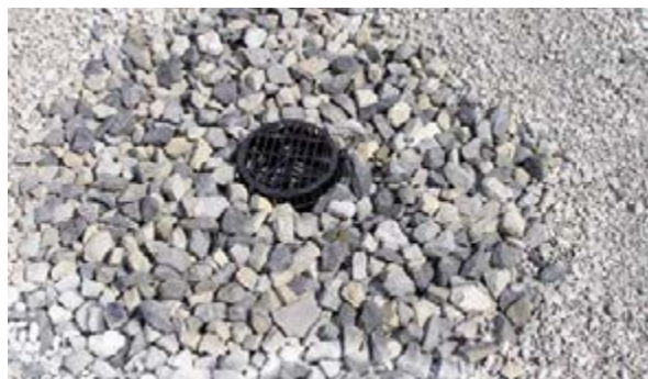
Рис. 2.4.5 Увеличение фракции балласта вокруг воронки
