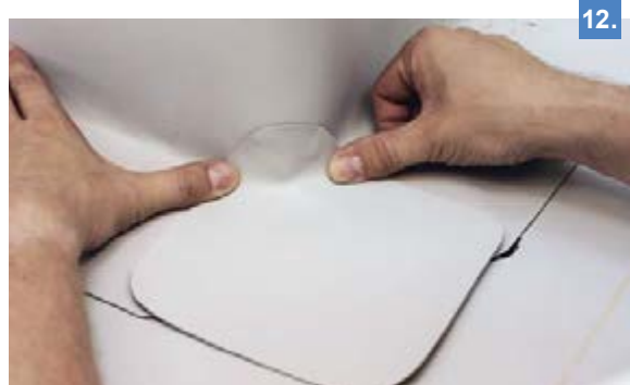
12. Примеряется полученная заготовка детали усиления. Она должна плотно прилегать ко всем сторонам изолируемого угла. При необходимости повторяются операции 10-11.
