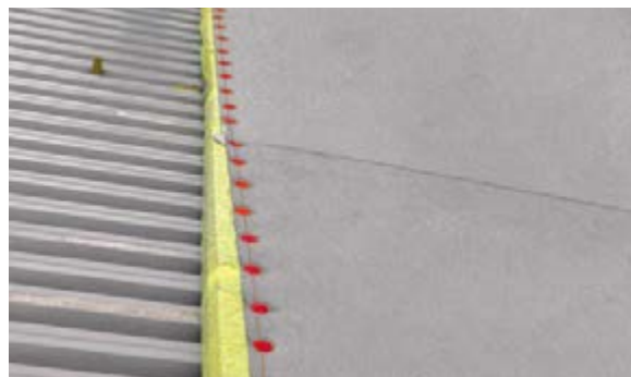
Рис. 3.1.7 Защита теплоизоляции от намокания
