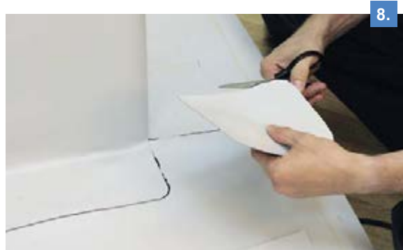
8. Из неармированного материала вырезается квадрат, как показано на рисунке. Скругляются все углы. Размер квадрата равен ширине горизонтального нахлеста плюс 3 см.
