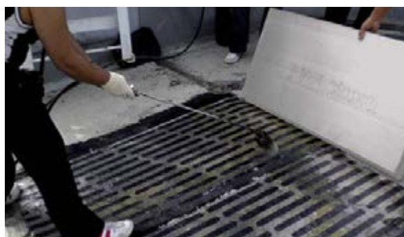
Рис. 2.6.5 Разогрев битумной поверхности для приклейки плит ТЕХНОНИКОЛЬ
