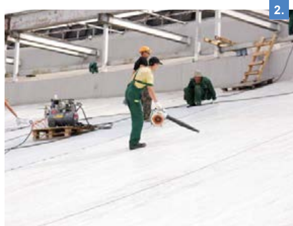
Рис. 2.6.6 - Рис. 2.6.7 Подготовьте старое основание: очистите, обеспыйте, просушите
