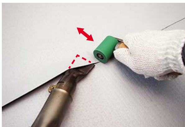
Рис. 5.2.7 Ручная сварка мембран
