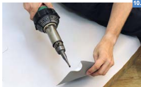
10. С помощью ручного фена прогревается один из углов детали.
