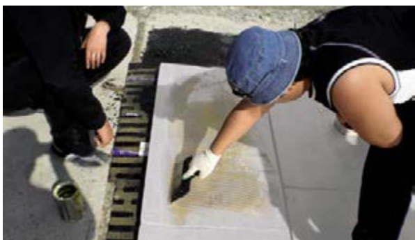
Рис. 2.6.4 Нанесение монтажного клея ТехноНИКОЛЬ
