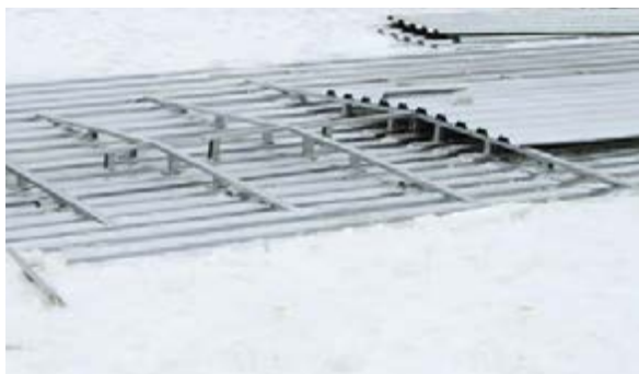
Рис. 3.3.4 Вариант устройства разуклонок
