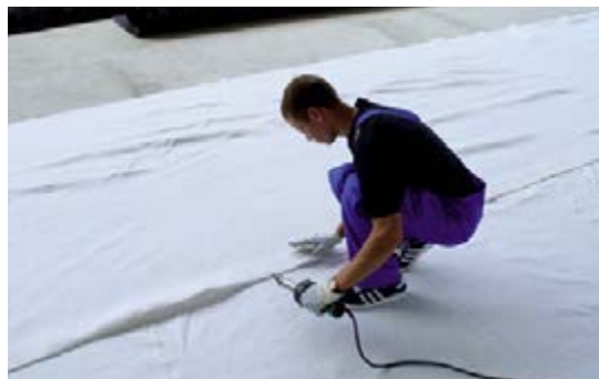
Рис.3.3.1 Сварка полотнищ геотекстиля между собой
