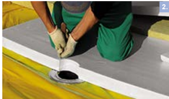
Рис. 3.6.10 Последовательность установки двухуровневой воронки
