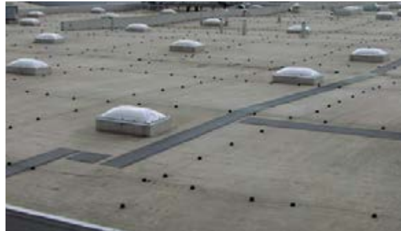
Рис. 3.6.4 Вид кровли с применением пешеходной дорожки ТехноНИКОЛЬ
