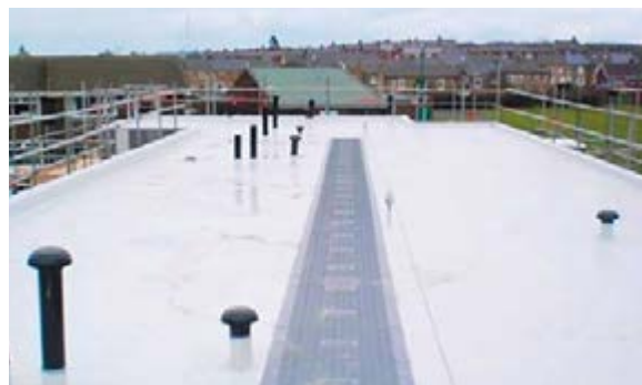
Рис. 4.2.5 Пешеходная дорожка ТехноНИКОЛЬ на кровле
