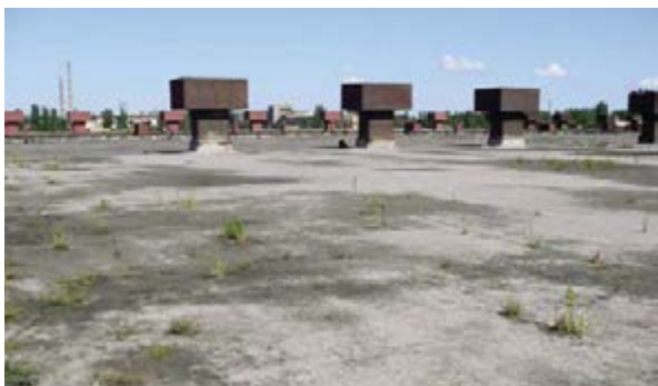
Рис. 2.6.1 Старая битумная кровля
