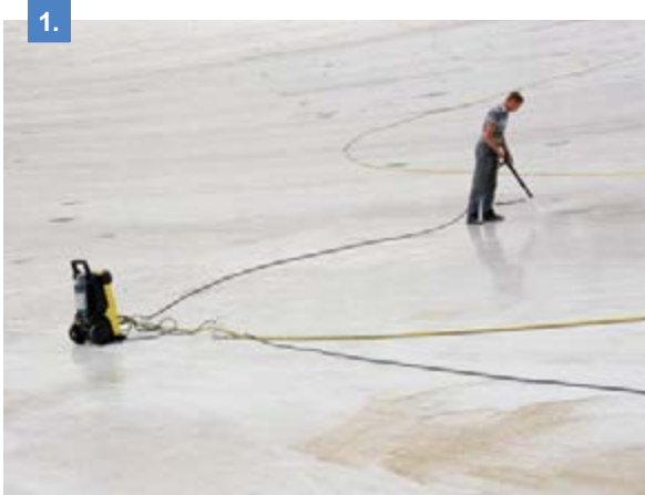
Рис. 2.6.6 - Рис. 2.6.7 Подготовьте старое основание: очистите, обеспыйте, просушите
