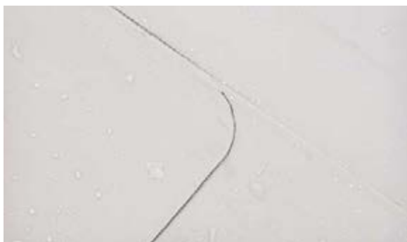
Рис. 5.4.1 Скругление углов мембраны
