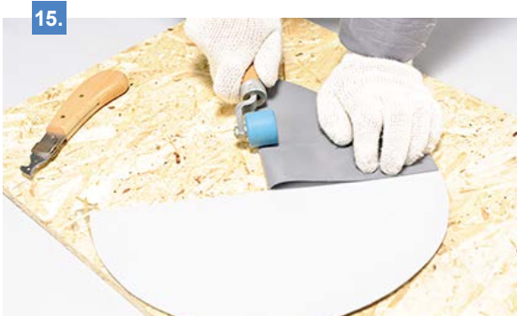
15. Загните получившийся сегмент и прикатайте его валиком.
