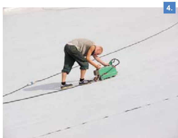
Рис. 2.6.9 После приклейки к основанию - мембрана сваривается обычным образом
