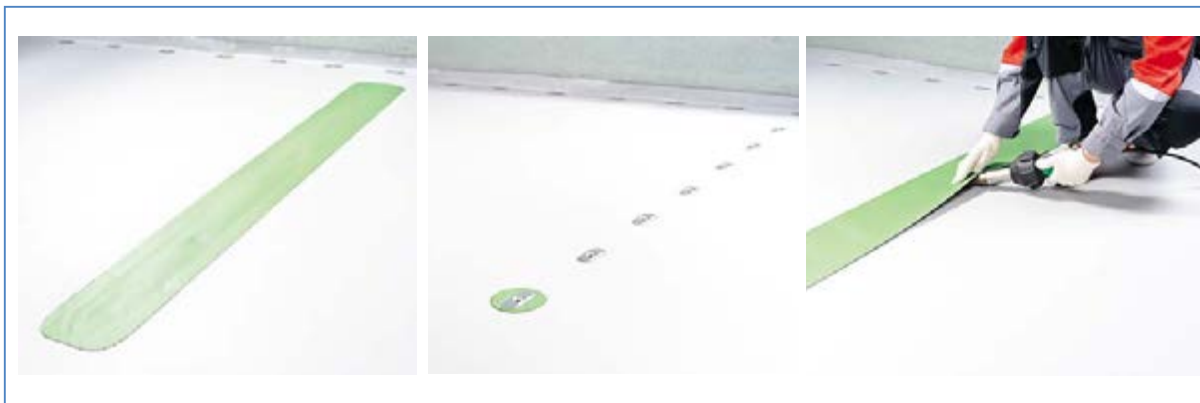
Рис. 3.5.13 Устройство дополнительного количества крепежа на полотне с приваркой полосы мембраны
