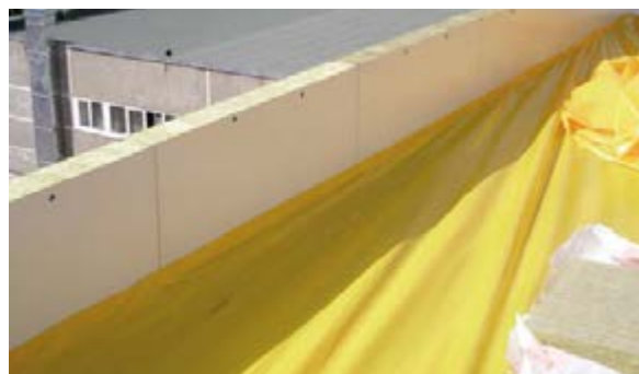
Рис.3.1.5 Укладка пароизоляционной пленки ТехноНИКОЛЬ
