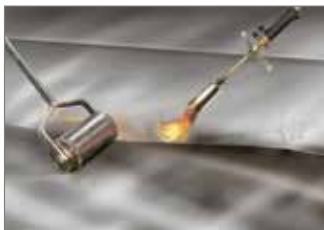
Свободная укладка с сплавлением швов
