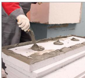
— Крепление плит производится аналогично креплению теплоизоляции в фасадной системе с тонким штукатурным слоем на полимерцементный клей либо любой другой, обеспечивающий хорошую адгезию к основанию, а также возможно крепление плит на приклеивающую мастику.
