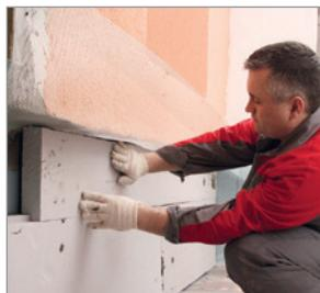
— Плиты экструзионного пенополистирола с наружной стороны должны быть защищены от активного воздействия солнечных лучей. Также рекомендуется в цокольной части здания обеспечить дополнительную антивандальную защиту.
