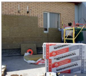
— Теплоизоляционные плиты накладываются на установленные в верхнем положении маятниковые рычаги. Монтаж плит производится снизу вверх. Установка плит выполняется с зубчатой перевязкой на углах и смещением швов по горизонтали. Вокруг оконных и дверных проемов вырезают целиковые элементы из плит.
