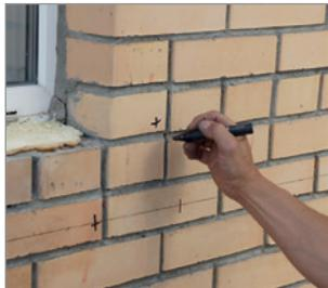
По отметкам устанавливаются скобы, которые крепятся к стене при помощи подходящих крепежных дюбелей. В скобу вставляется маятниковый рычаг, который фиксируется в верхнем положении под углом 90° для легкого монтажа теплоизоляции.
