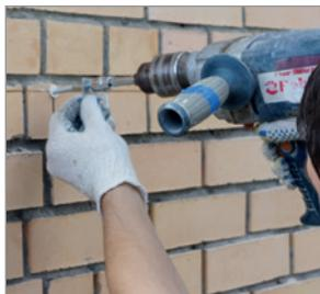
Перед началом установки крепежных изделий выбранный дюбель в соответствии с типом стены забивают в отверстие.
