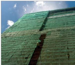
— Необходимо защитить монтируемый фасад от атмосферных осадков и от прямых солнечных лучей. Для этого сверху устраивается ограждение, а по периметру леса обтягивают защитной строительной сеткой.
