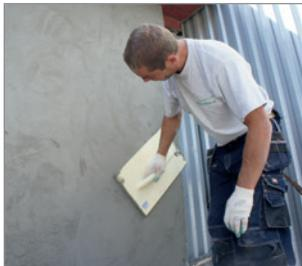
Раствору дают схватиться в течение 1–3 ч (в зависимости от погоды), после чего производят затирку выровненной поверхности теркой с полиуретановым покрытием.
