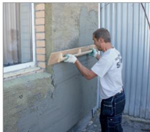
После механического нанесения штукатурный раствор разглаживают правилом, слегка придавливая к теплоизоляции, одновременно проверяя, чтобы сетка была полностью покрыта раствором. Во избежание выпирания сетки оштукатуривание лучше выполнять снизу вверх. При выравнивании первого слоя необходимо проверять его толщину по всей поверхности и, где необходимо, добавлять раствор.
