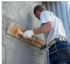
Назначение второго штукатурного слоя — выровнять конструкцию стены и создать прямую и ровную основу для нанесения финишного защитно-декоративного слоя. Расход раствора для второго слоя — 15–20 кг/м<sup>2</sup>. Перед нанесением второго слоя раствора первый слой следует увлажнить за 1–2 ч до начала работ. Второй слой можно наносить вручную или механически, плотно прижимая к основе,
