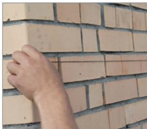
Стену при помощи цветного шнура делят на квадраты со стороной 500 мм, начиная от угла и учитывая, что первая линия проводится на расстоянии 150 мм от угла. В местах пересечения линий, где будут сверлиться отверстия крепежа, делают отчетливые отметки.
