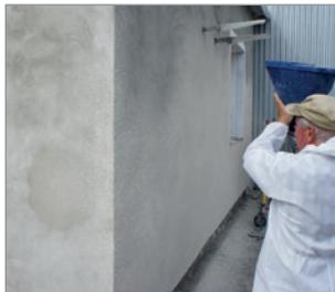
— Защитно-декоративный штукатурный слой предохраняет конструкцию от климатических воздействий и определяет цветковое решение и фактуру фасада здания.
