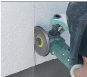
Армированный базовый штукатурный слой после полного затвердевания прорезают на всю толщину горизонтальными и вертикальными швами шириной 6 мм с шагом не более 15 м. Крайний вертикальный шов должен располагаться не ближе 150 мм от угла фасада здания. Горизонтальные швы заделывают отверждающей мастикой (силиконовой или тиоколовой).
