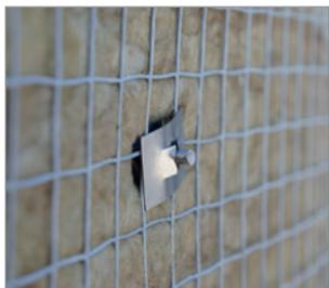
Перед началом установки сетки необходимо убедиться в том, что все крюки, являющиеся составной частью крепежного изделия, выведены из блокировочного положения и установлены под заданным углом не менее  $30^\circ$ . Сетку натягивают полосами, равными ширине рулона, раскручивая рулон сверху вниз. Нахлест сетки должен составлять не менее 50 мм.
