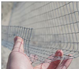
Первый ряд минераловатных плит укладывают в желоб из сетки, установленный на линии цоколя. Основная задача стартового профиля из сетки — задать четкую геометрию фасадной системы.
