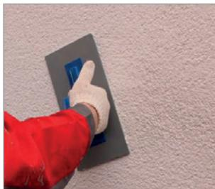
Декоративный узор штукатурки придается однообразным растиранием нанесенной смеси пластиковой теркой. Данная операция производится до высыхания смеси. Затирку производить, не дожидаясь обветривания поверхности, «по-сырому».
