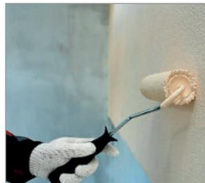
При необходимости поверхность фасада может быть дополнительно окрашена фасадными красками. Но не ранее, чем через 7 дней после монтажа штукатурки. В процессе нанесения и сушки штукатурка должна быть защищена от прямых солнечных лучей, дождя и ветра.
