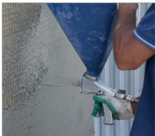
Штукатурный раствор можно наносить механически (растворонасосом) или вручную стальным шпателем, придавливая его к сетке и теплоизоляции. При необходимости сетку оттягивают от минераловатной плиты так, чтобы штукатурный раствор покрывал ее с обеих сторон полностью. Если сетка в некоторых местах деформируется и выпирает из раствора, ее вдавливают внутрь раствора, закрепляя специальными оцинкованными гвоздями.
